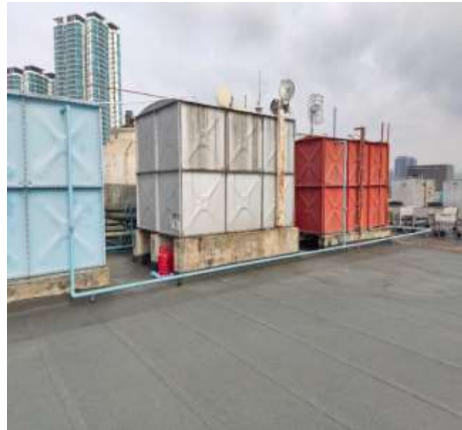
Strateq Data Centre
