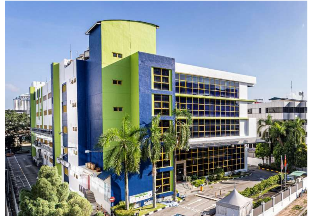
Strateq Data Centre
